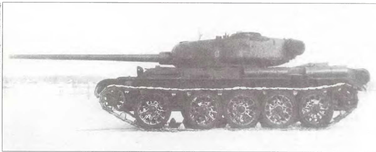
Первый прототип танка Т-54, вооруженный 100-мм пушкой Д-10. Март 1945 года
